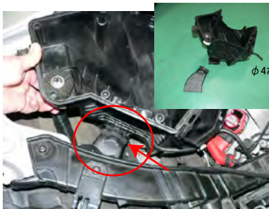
ボックス下側の導入ダクトを回転させて外します。φ4ホースも外します。
